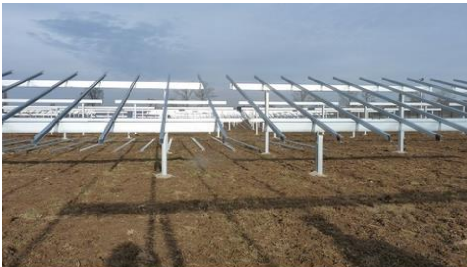
Zdj.2. Przykład konstrukcji stelażowej służącej do montażu paneli fotowoltaicznych (na podst. chronymy klimat.pl )
