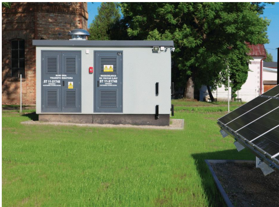
Zdj.3. Przykład kontenerowej stacji transformatorowej, w której umieszczony jest transformator (na podst. gosolar.pl)
