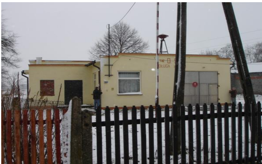
Rysunek 8.3. Budynek Strażnicy OSP w Długiej Wsi Trzeciej – budynek z ogrodzeniem
