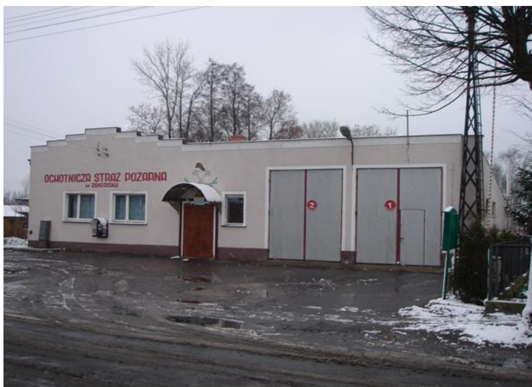
Rysunek 8.3. Budynek Strażnicy OSP w Zbiersku – widok od strony drogi
