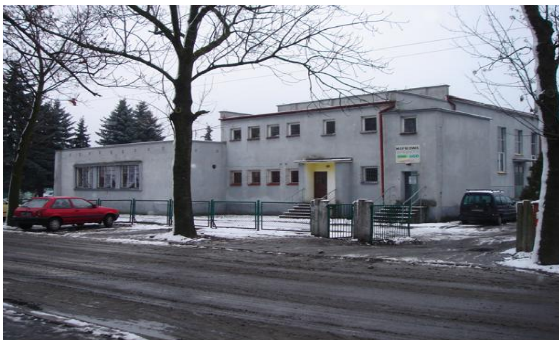
Rysunek 8.3. Budynek MGOK w Zbiersku Cukrowni – widok od strony drogi
