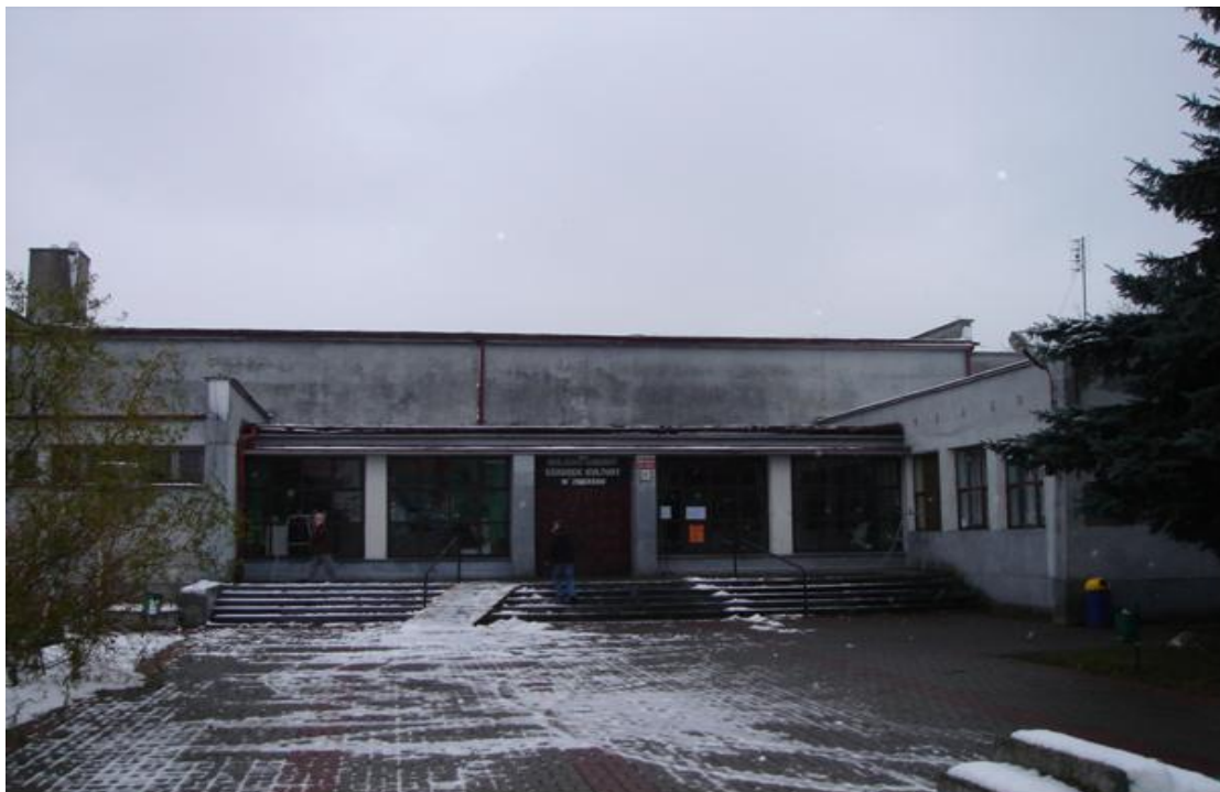
Rysunek 8.2. Front budynku MGOK w Zbiersku Cukrowni
