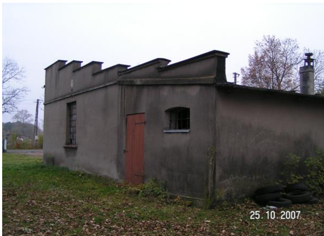
Rysunek 8.4. Budynek Strażnicy OSP w Zbiersku Kolonii – elewacja boczna
