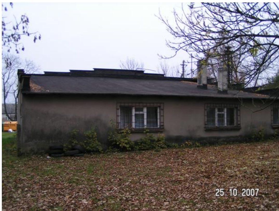
Rysunek 8.3. Budynek Strażnicy OSP w Zbiersku Kolonii – elewacja tylna
