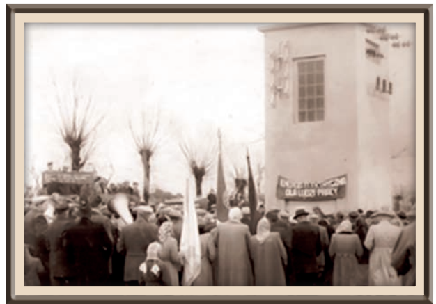
Uroczystość uruchomienia sieci elektrycznej, podłączenie do transformatora przy ul. Szkolnej w Stawiszynie, 1956 r.
