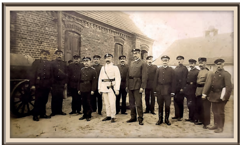
Członkowie Straży Ogniowej w Stawiszynie, przed nowym murowanym budynkiem remizy. Poprzedni uległ spaleniowi w 1914 r.
