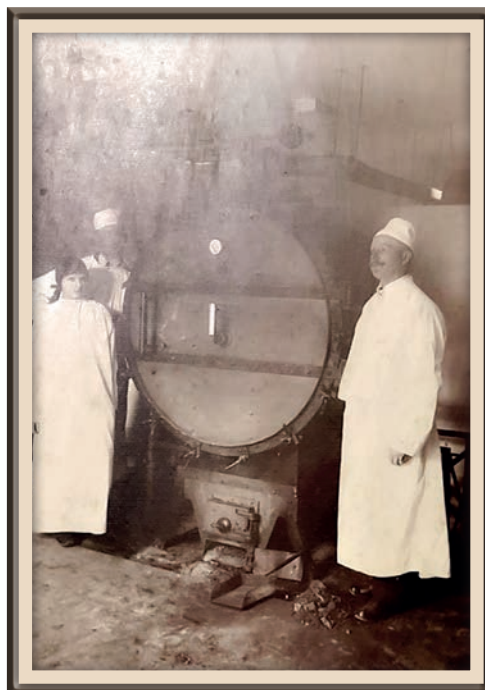
Pomieszczenie gospodarcze w przychodni lekarskiej. Na zdjęciu piec z kotłem, który służył do podgrzewania wody do kąpeli chorych, 1928 r.
